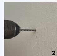
Bohren Sie die Löcher für die Dübel an den markierten Stellen mit einem 7 mm Bohrer.
