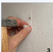
Setzen Sie die beiden Dübel in die Löcher ein und achten Sie darauf, dass sie nicht überstehen.
